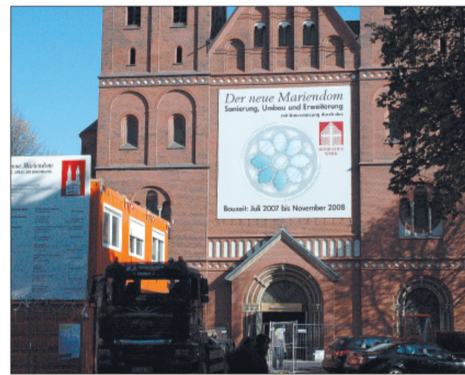
Die Bauarbeiten in der Domkirche werden ausgeweitet. In wenigen Tagen werden auch Flächen an der Südseite gesperrt sein. Foto: Andreas Hüser
